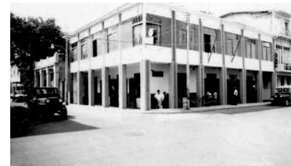
Antiguo edificio del Municipio de Portoviejo. Esquina de las calles Córdova y Chile.
